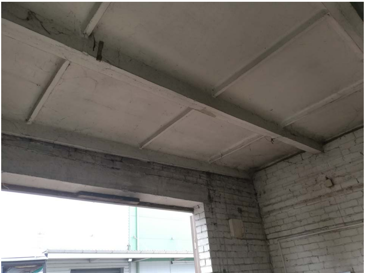
06 pav. Nagrinėjamo statinio šiaurinio tūrio stogo konstrukcijų fotofiksacija
