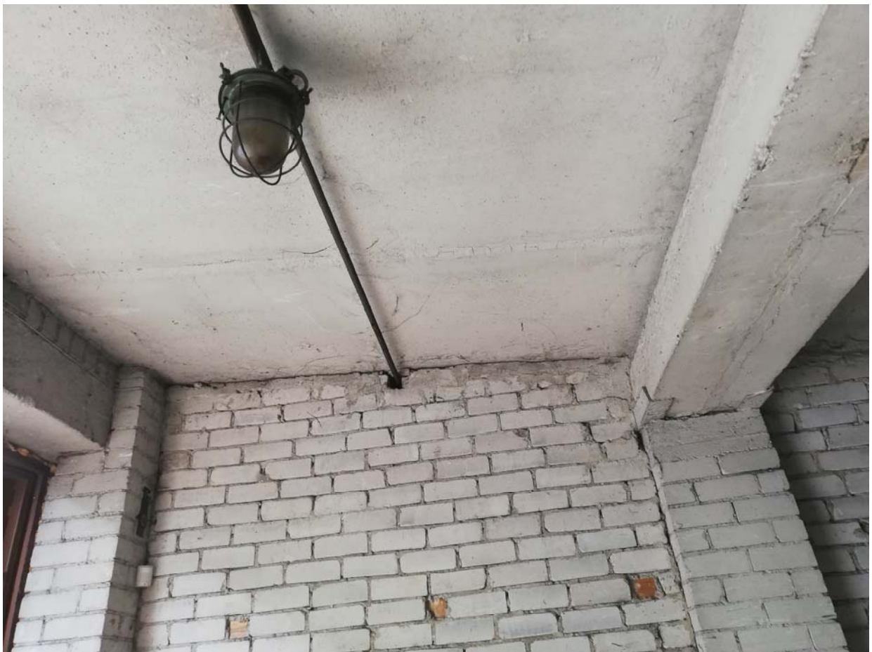
08 pav. Nagrinėjamo statinio pietinio tūrio stogo konstrukcijų fotografacija
