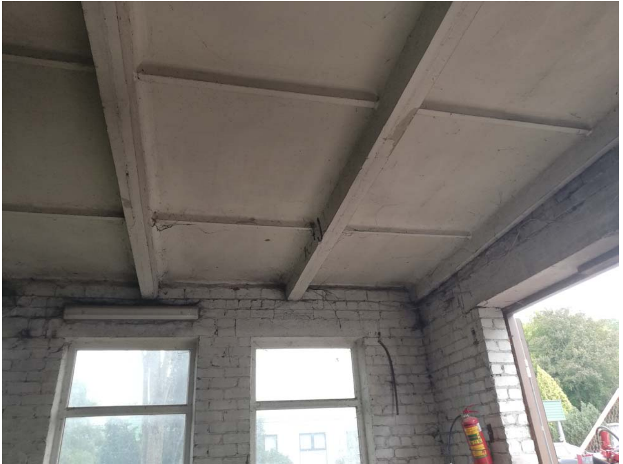
05 pav. Nagrinėjamo statinio šiaurinio tūrio stogo konstrukcijų fotofiksacija
