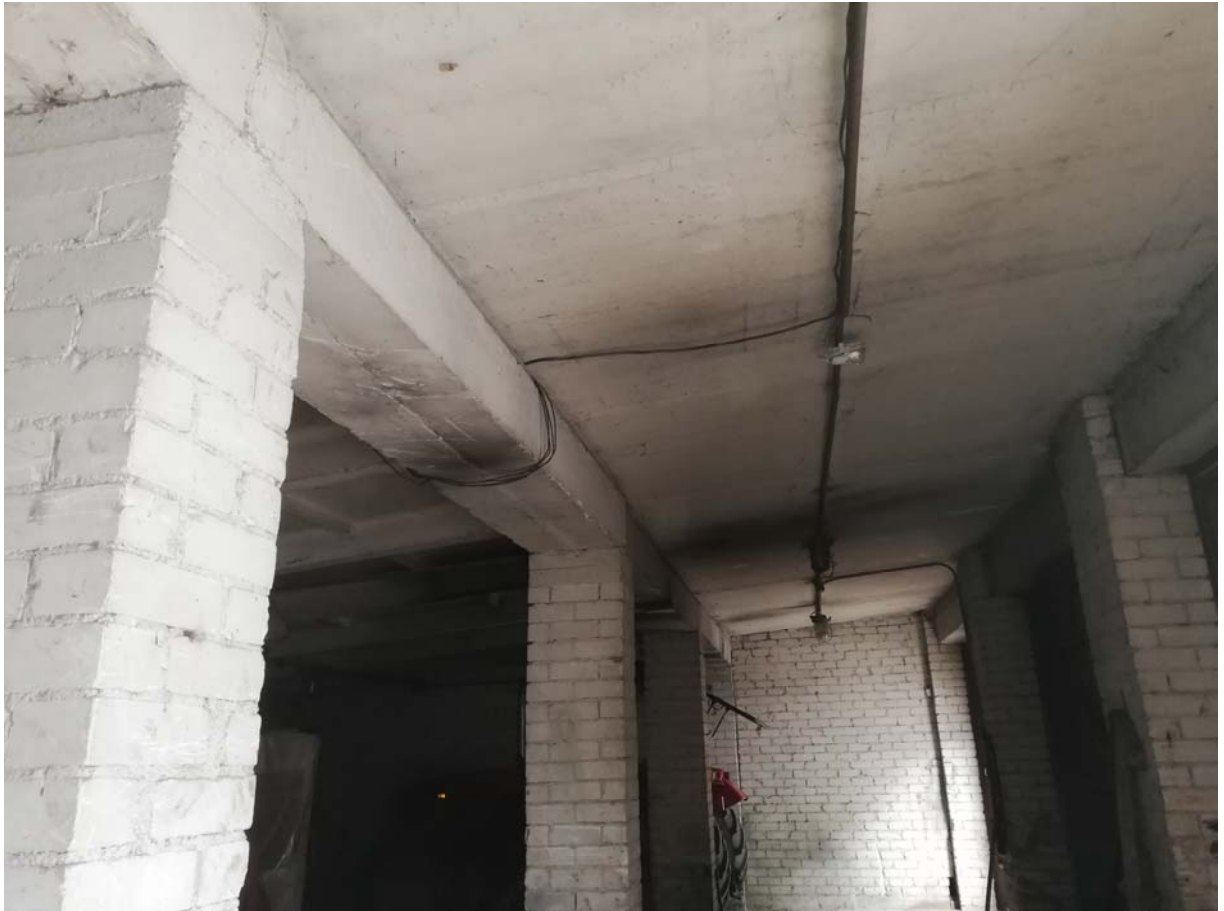
10 pav. Nagrinėjamo statinio pietinio tūrio stogo konstrukcijų fotofiksacija
