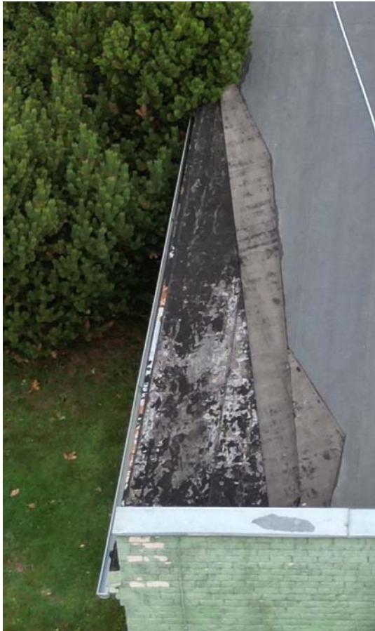
03 pav. Stipraus vėjo metu (2023.10.) pietvakariniame kampe atplėšta prilydoma stogo danga. Prieš įrengiant fotovoltinę jėgainę atlikti stogo dangos paprastojo remonto darbus
