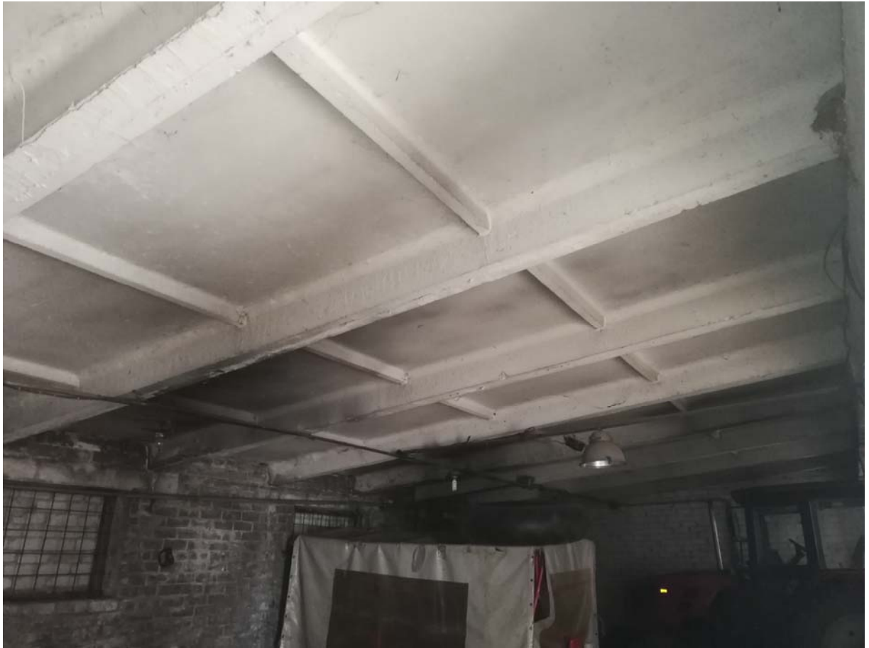
09 pav. Nagrinėjamo statinio pietinio tūrio stogo konstrukcijų fotofiksacija
